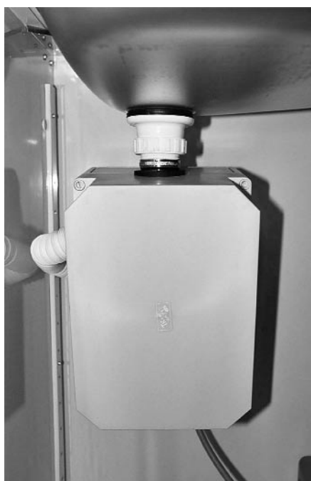
Abbildung 1: Selbstdesinfizierender Geruchsverschluss unter einem Waschbecken der chirurgischen Intensivstation der Oberlausitz-Kliniken gGmbH in Bischofswerda.
